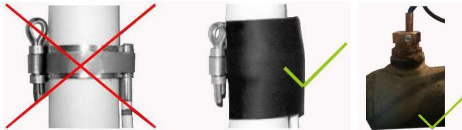
Abb. Nr. 8 – Anschluss der Wärmesensoren
