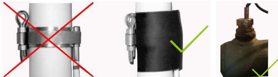
Abb. Nr. 8 – Anschluss der Wärmesensoren
