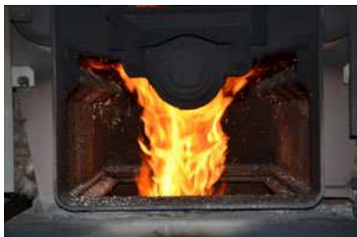
Obr. č. 13 Optimální tvar plamene
