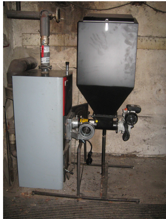
Abb. Nr. 5 – Montage in die Vordertür
